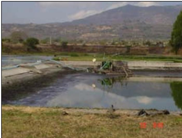
**Figura 18– Reducción de nivel de agua en la laguna primaria “A”**
