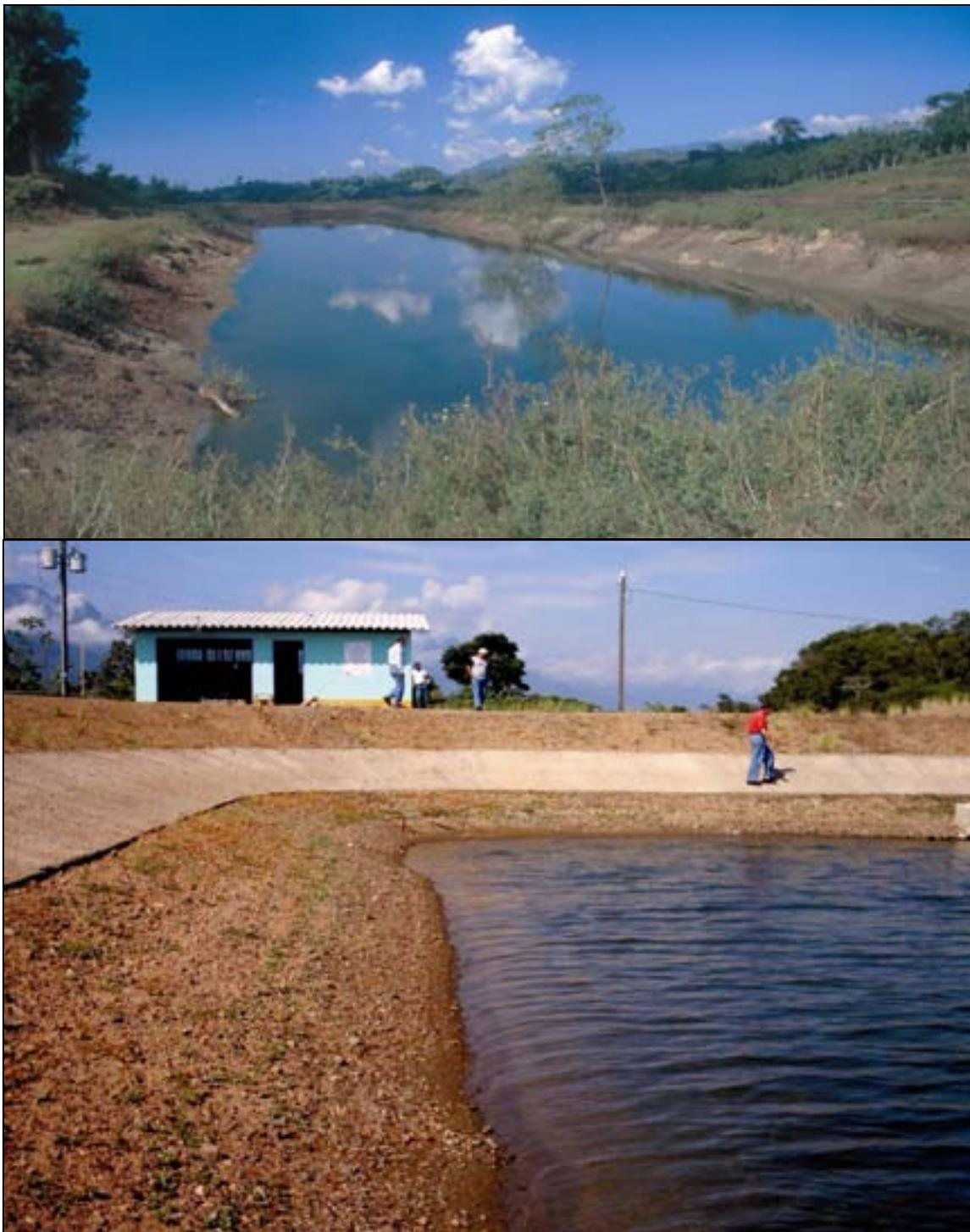
**Fotos 6-4:** Ejemplos de la importancia del balance hídrico. En las dos fotos las pérdidas por infiltración son excesivas y no se puede mantener el nivel de agua en las lagunas. Las dos lagunas faltan impermeabilización adecuada de arcilla. (Arriba: Zaragoza, El Salvador; abajo: La Ceiba, Honduras. Foto abajo cortesía de Ing. Iván Olivieri.)
