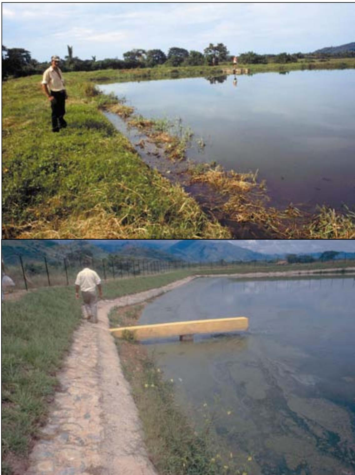
**Fotos 6-18:** En la foto arriba (Tela, Honduras) la laguna facultativa tiene problemas con el crecimiento de hierbas acuáticas en la orilla por falta de un revestimiento. En la foto abajo (Catacamas, Honduras) la deficiente construcción del revestimiento (notase las curvas de nivel) con insuficiente borde libre no previene el crecimiento de plantas acuáticas en la orilla.
