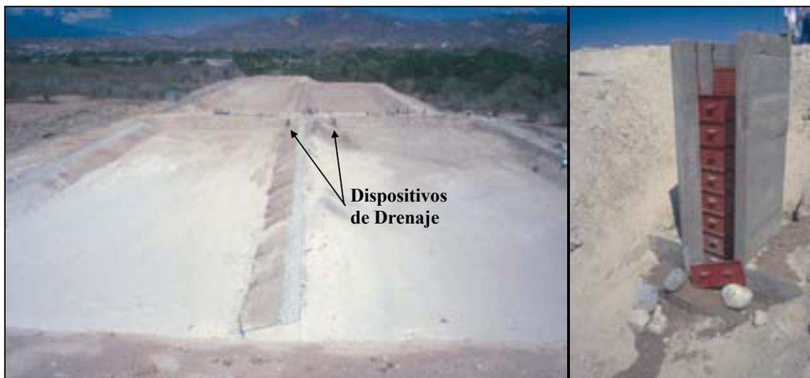
**Fotos 6-16:** Un ejemplo de dispositivos de drenaje instalados en el lado de descarga de una batería de lagunas facultativas. Los dispositivos tienen compuertas lo que permiten el gradual drenaje cuando sea necesario para remover lodos acumulados. (Estanzuela, Guatemala)
