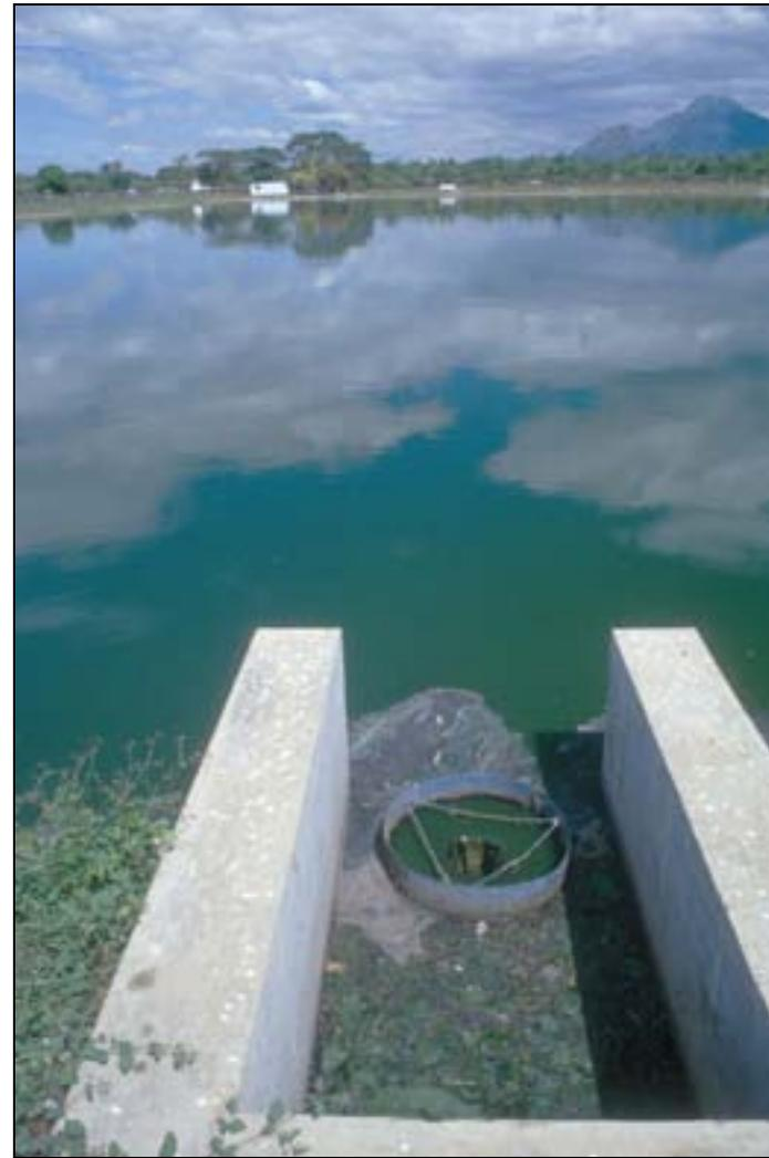
**Fotos 7-6:** En la foto a la izquierda, la salida de una laguna facultativa diseñada con una compuerta de fondo y un vertedero rectangular no tenía la compuerta y como resultado, los sólidos flotantes estaban saliendo con el efluente y la eficiencia de remoción de  $\text{DBO}_5$  y coliformes fecales estaba baja (Catacamas, Honduras). La foto a la derecha muestra una pantalla circular utilizado para controlar la salida de natas en el efluente de una laguna facultativa (Chinendega, Nicaragua)
