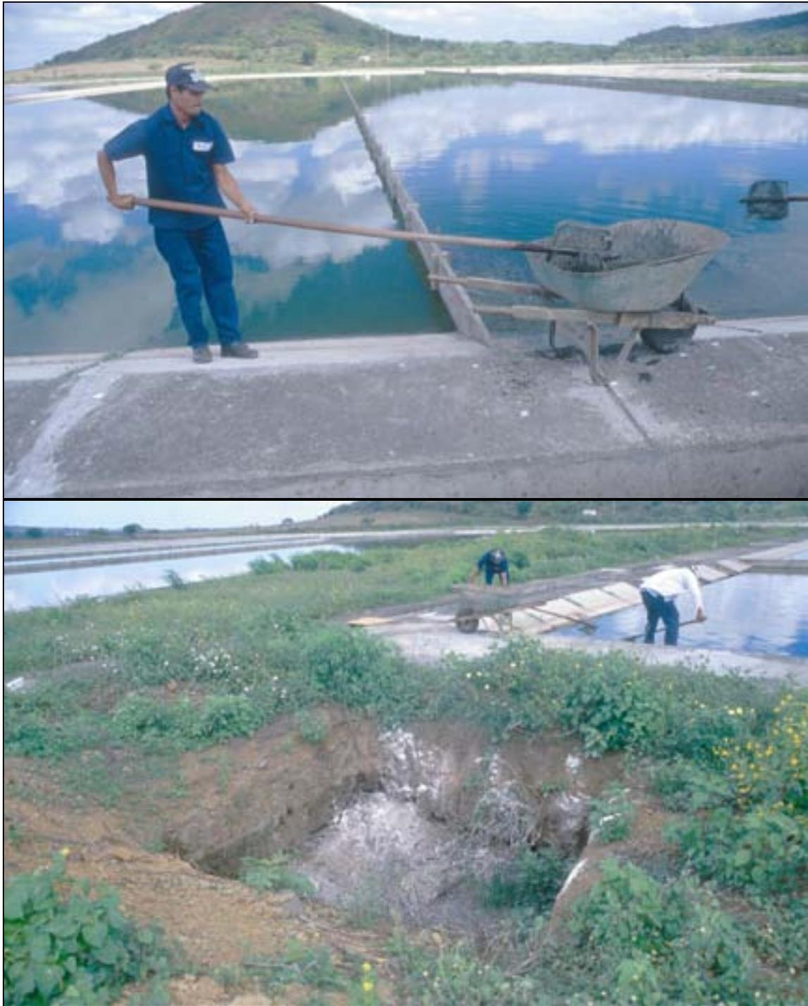
**Fotos 7-5:** Las natas y sólidos flotantes se acumulan en las esquinas de las lagunas, donde el operador puede sacarlos fácilmente con un desnatador y ponerlos en una carretilla. Después, se debe enterrarlos, o cubrirlos con una capa de suelo o cal. En la foto abajo los operadores ponen las natas recolectadas en un pozo y los cubren con cal para controlar olores. Cuando se llena la excavación se cubre con una capa de suelo. (Masaya, Nicaragua)
