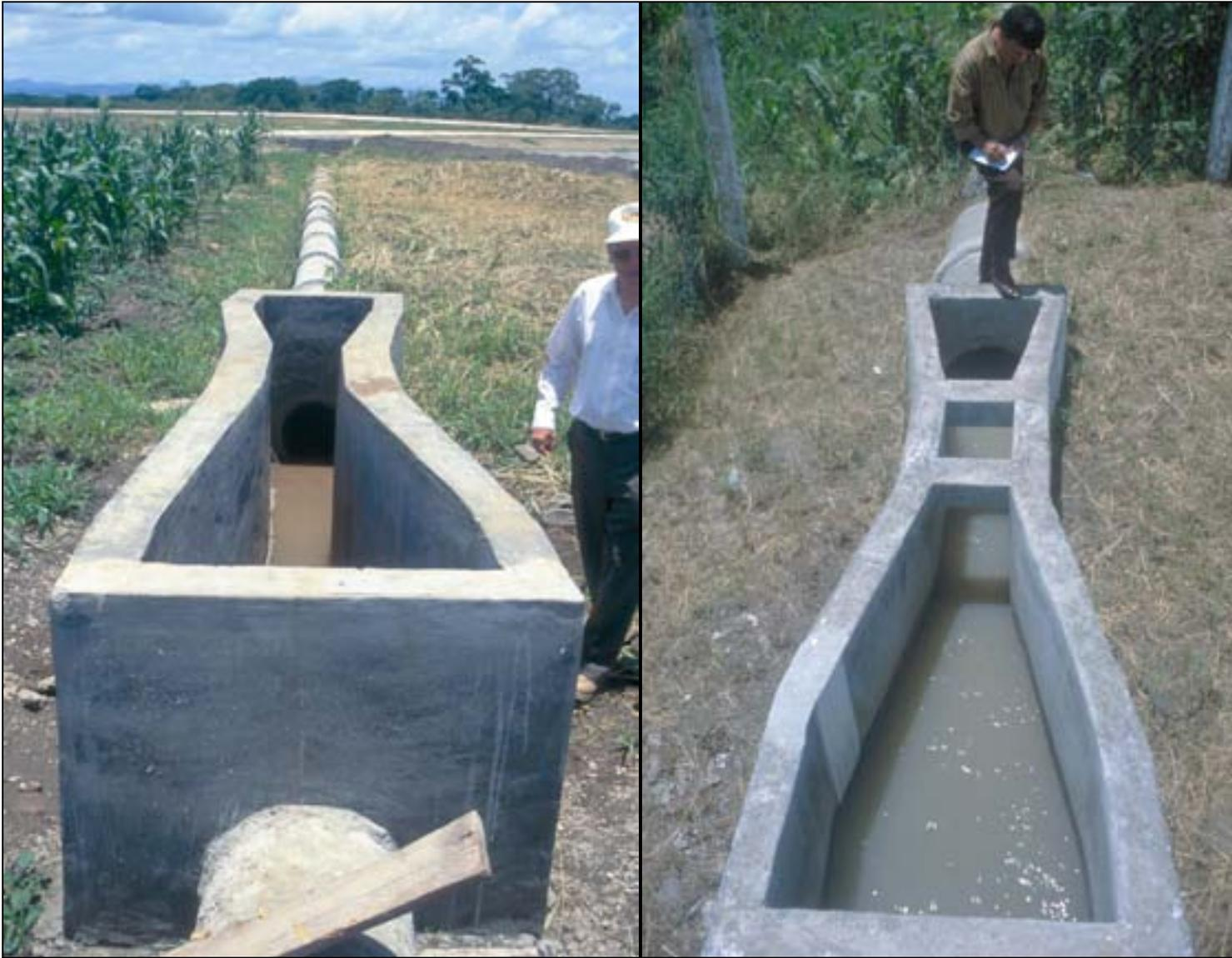
**Fotos 3-12:** Ejemplos de canaletas Parshall de concreto que no sirven por su mala construcción (nótese las dimensiones irregulares) y el hecho que no cuentan con flujo libre como se ve en las Fotos 3-11. Nunca se debe diseñar canaletas Parshall de concreto. (Foto izquierda: Catacamas, Honduras; derecha: Villanueva, Honduras)
