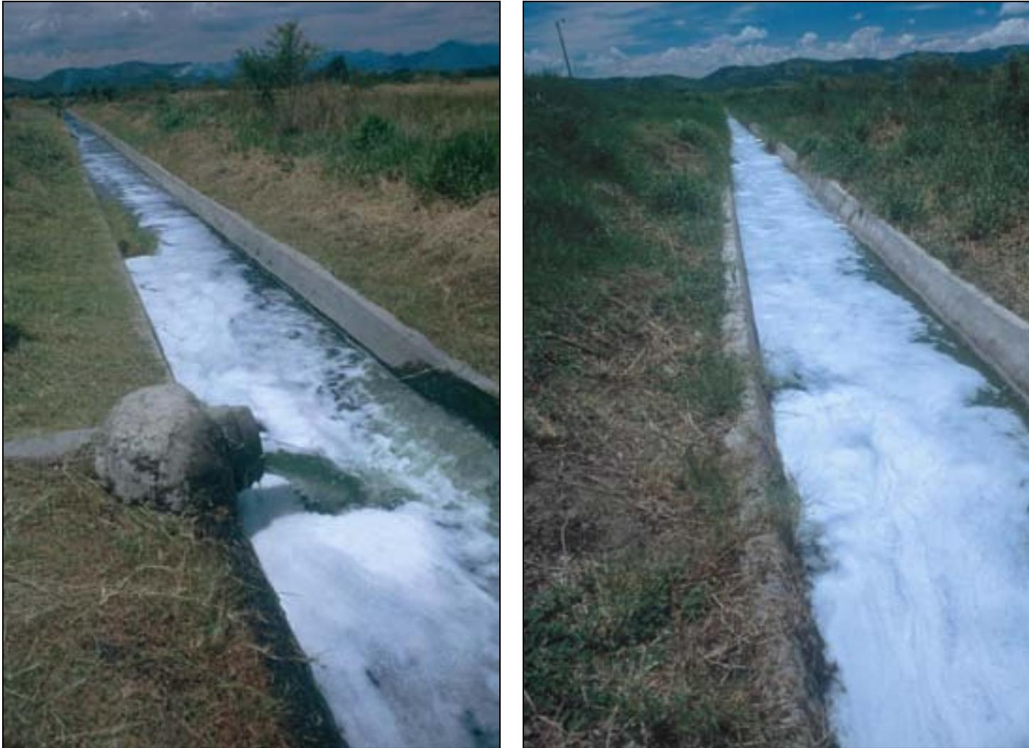
**Fotos 6-15:** Un ejemplo de la espuma que puede ser formada por la turbulencia cuando la descarga final está arriba del nivel de agua en el cuerpo receptor. La espuma es causada por los detergentes y otros tensoactivos no biodegradables en las aguas residuales. La manera de controlar la producción de espuma es de utilizar dispositivos de descarga abajo el nivel de agua como se presenta en la Figura 6-5. (Villanueva, Honduras)
