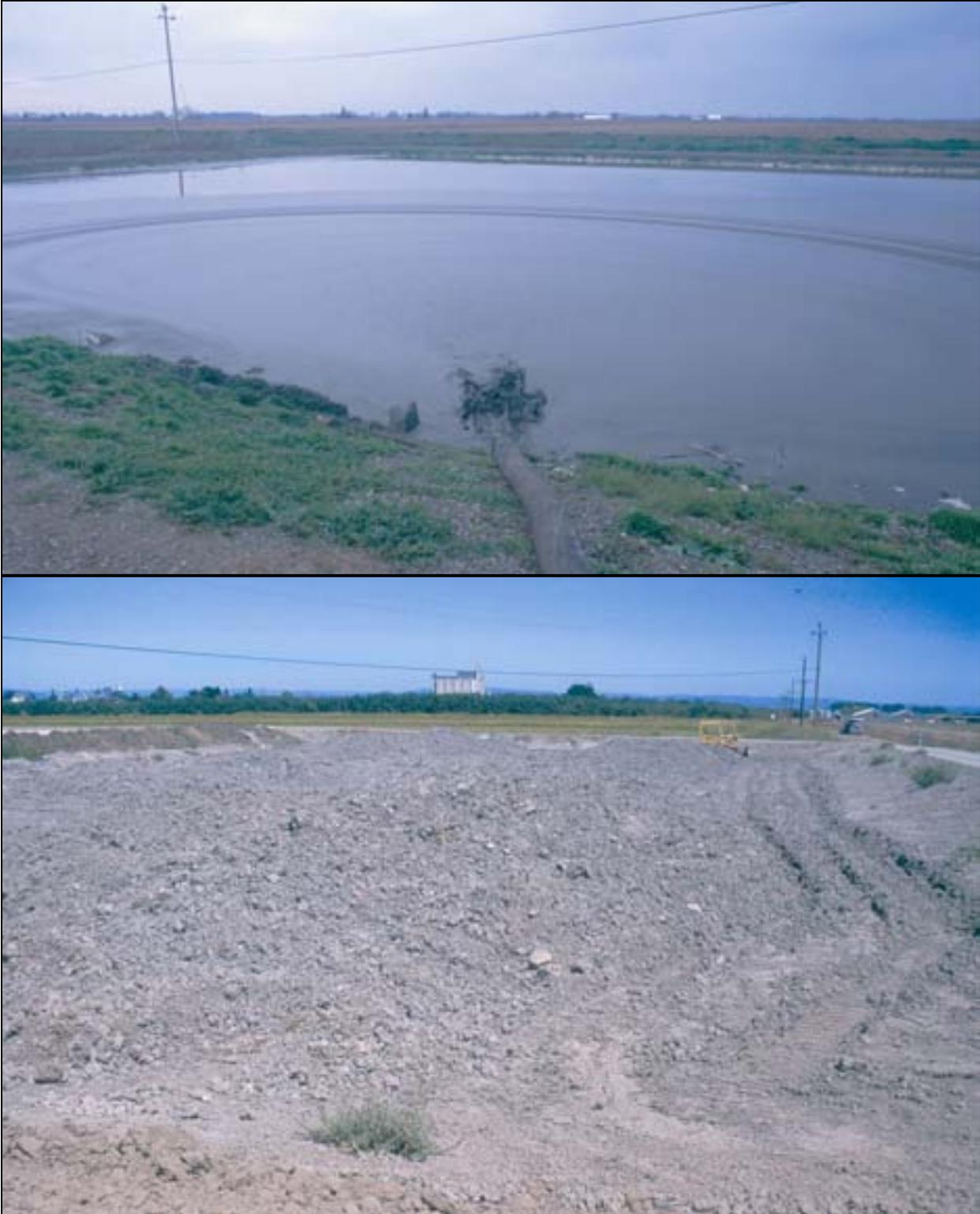
**Fotos 8-5b:** El lecho de secado recibiendo los lodos bombeados de la laguna primaria (foto arriba) y los lodos dos meses después de secar (foto abajo). El lecho de secado fue construido con un drenaje para los lixiviados, lo que llevaba los lixiviados a la otra laguna en operación. Después de secar los lodos fueron llevados a un relleno sanitario. (Biggs, California)
