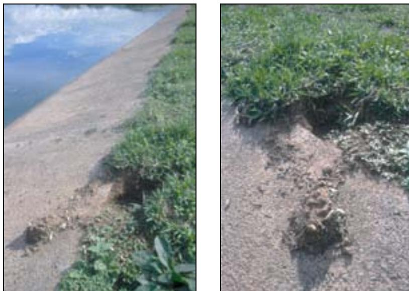
**Fotos 7-11:** Las tortugas pueden excavar atrás y abajo del revestimiento para depositar sus huevos. El operador debe monitorear la condición del revestimiento de rutina cuando hay poblaciones altas de tortugas. (Danlí, Honduras)
