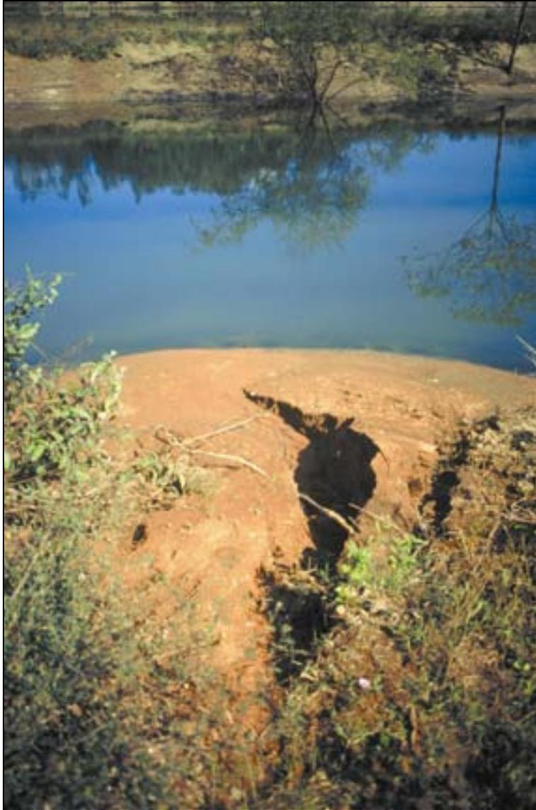
**Foto 6-2:** El escurrimiento de agua pluvial tiene que ser controlado para proteger el terraplén y los taludes de una laguna. En esta laguna de maduración el escurrimiento de agua pluvial no fue controlado y está causando erosión al talud interior. (Zaragoza, El Salvador)
