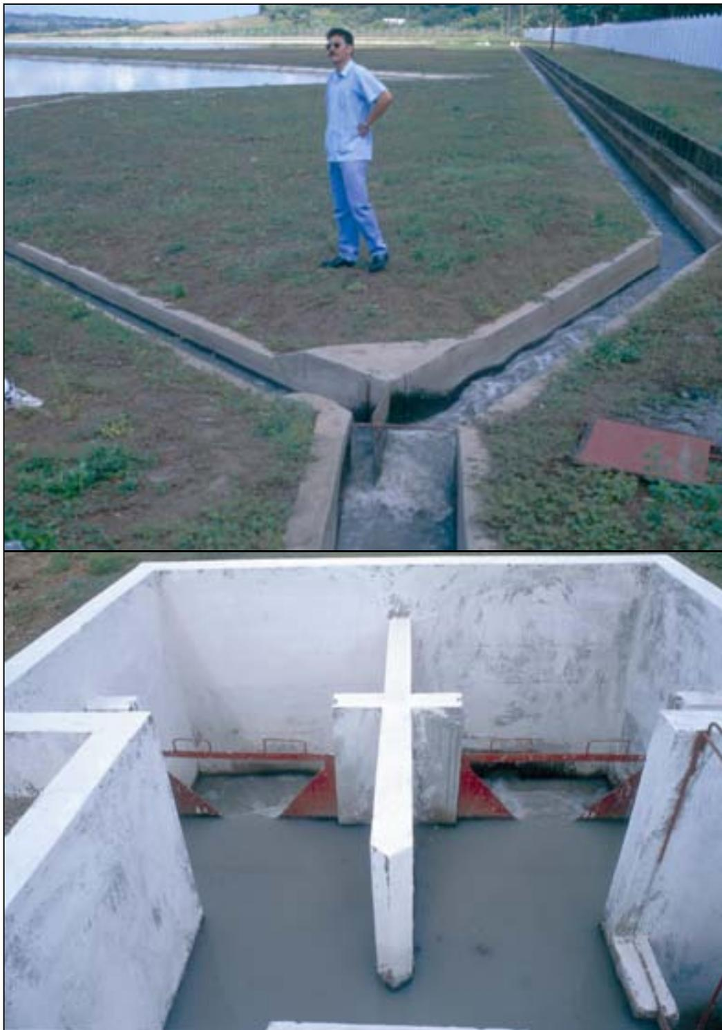
**Fotos 6-12:** Ejemplos de dispositivos para la repartición de caudales entre baterías de lagunas facultativas en paralelo. En la foto arriba (Masaya, Nicaragua), se utiliza un tabique divisorio ajustable, y en la foto abajo (Granada, Nicaragua), un tabique divisorio combinado con vertederos triangulares ajustables. Se debe medir los caudales a cada laguna para estar seguro de la repartición.
