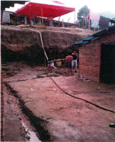
Es de anotar que por falta de mantenimiento los empaques de las bombas están regando agua tratada y las mangueras tiene varias roturas por donde se desperdicia agua tratada y potable.
