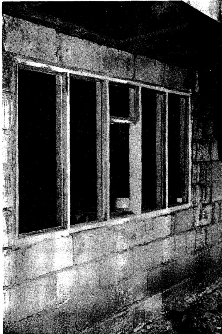
Foto 2. Se nota la falta de viga corona y cargador, lo que hizo que la estructura no actuara como un todo.
