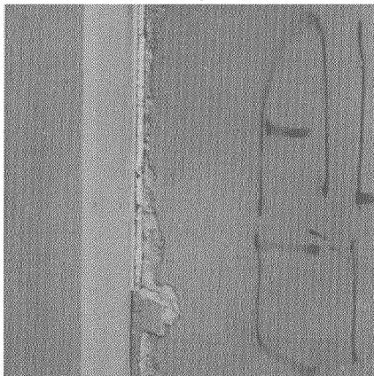
Fig. 19 - Facultad de Medicina, Universidad Nacional de El Salvador - La estructura a base de pórticos de concreto reforzado, mostró buen comportamiento en el terremoto de 1986. Juntas de separación entre tabiques y sistema resistente evitaron el efecto de columna corta y daños a la mampostería.
