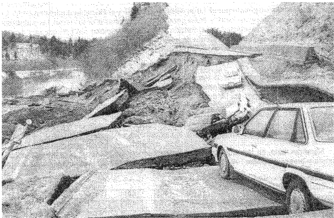
Enero 16, 1993. Automóviles abandonados sobre la carretera nacional, destruida luego del terremoto de Kushiro-Oki. (Foto provista por el periodico Mainichi Shinbun)
