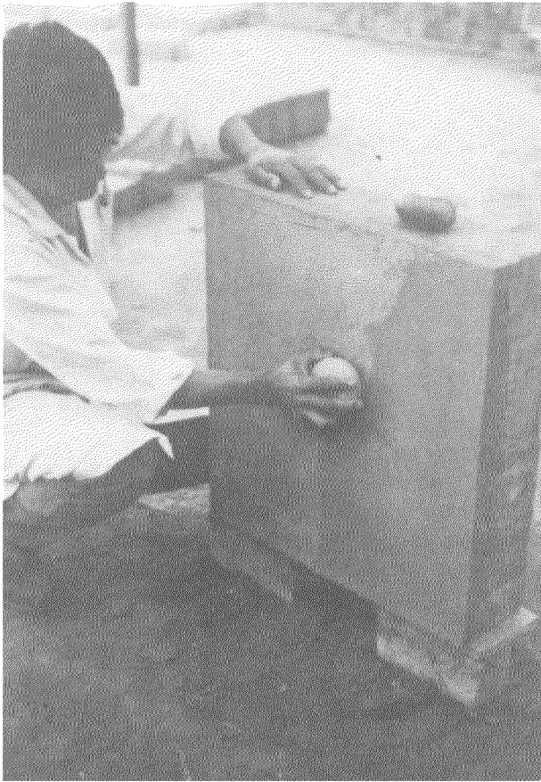
Fig. 2.2 Pulido de la Superficie del Enlucido.
