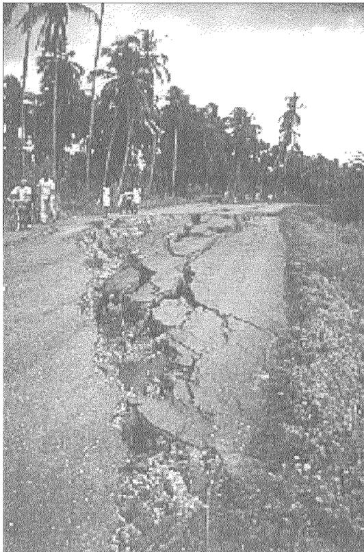
**Fig. 3.13 Separación lateral por licuefacción durante el terremoto de Limón, Costa Rica (1991), carretera Limón-Cahuita (Foto R. Mora).**
