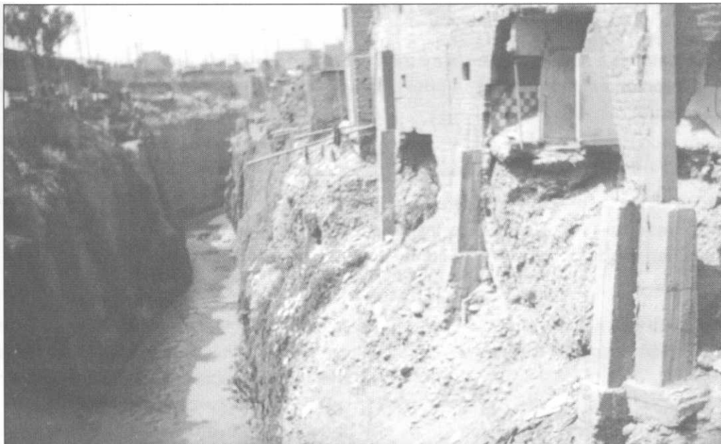
Figura 2. Río Rímac visto en dirección aguas arriba entre los puentes El Ejército y Dueñas (Lima, Perú).
