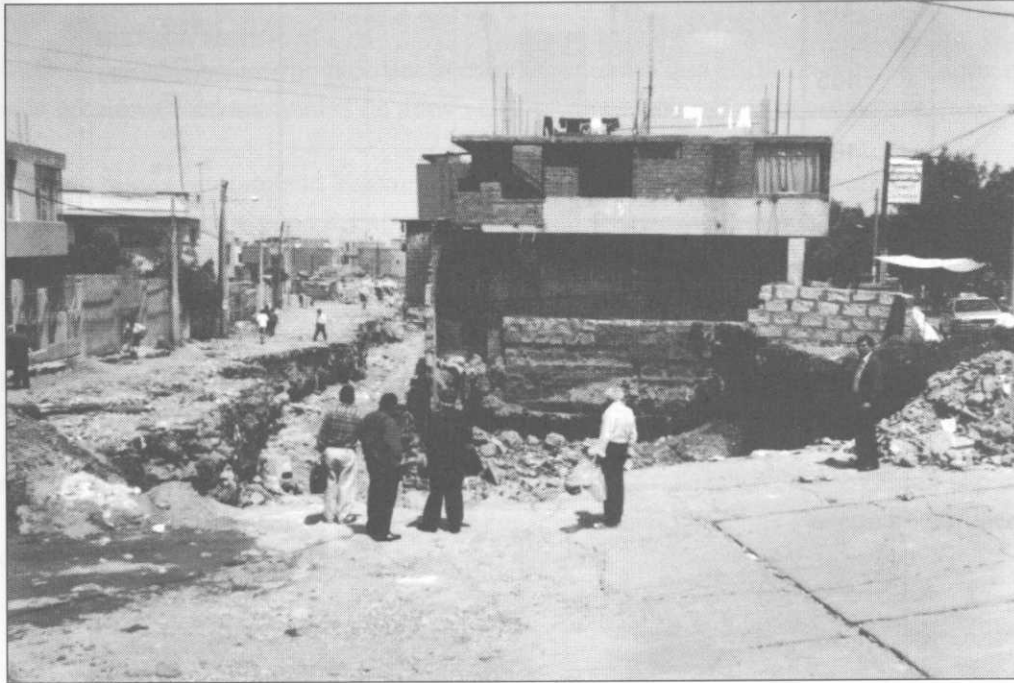
Figura 1. Vivienda ubicada al pie de una torrentera en Arequipa (Sur del Perú). Nótese que la erosión continua ha ocasionado la pérdida de habitaciones.
