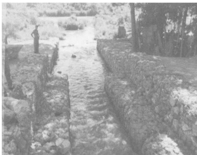
Desfogue de PTAR Rafey antes de la prolongación del muro de gaviones con la intersección del muro de contención del INDRHI
