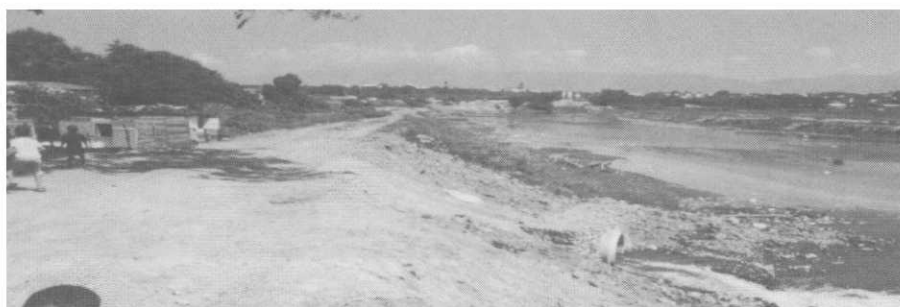
Muro de contención construído
