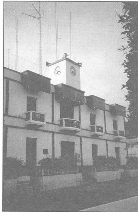
Figura 5.10 Palacio Municipal de Motozintla
