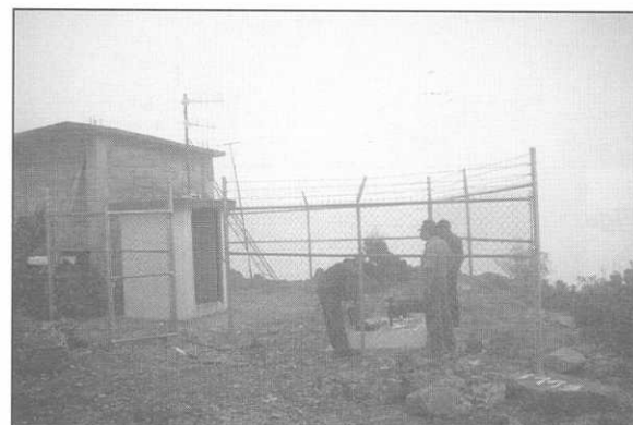
Figura 5.12 Vista de la estación repetidora en Mozotal
