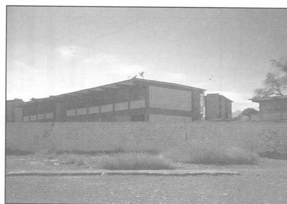
Figura 7.5 Escuela en la que se encuentra la estación Las Mitras, MI-02
