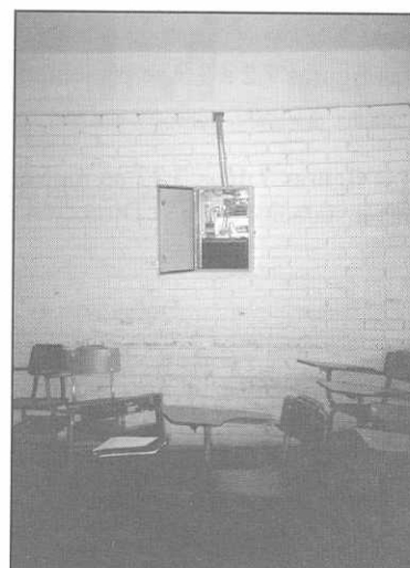
Figura 7.3 Gabinete con el equipo electrónico de registro y comunicaciones dentro de un salón de clases, estación
