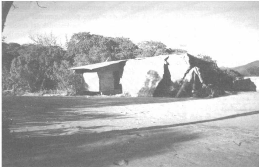
**Figura 2.6 Falla de una estructura de mampostería confinada por efecto del viento (H. Toledo; Oaxaca, México, 1999)**
