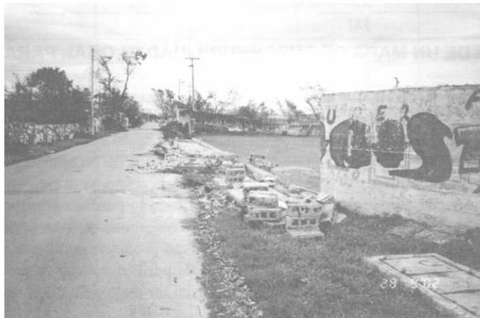
**Figura 3.2 Daños y falla en muros de mampostería usados en bardas de colindancia**
