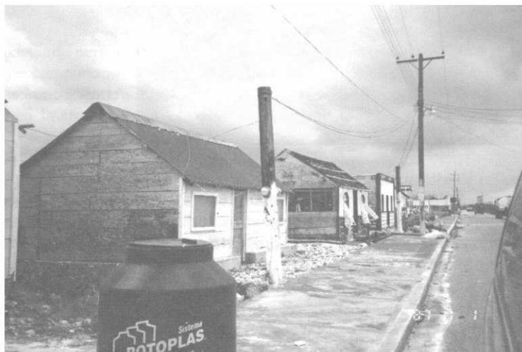
Figura 4.11 Comportamiento de edificaciones de vivienda en la ciudad de Telchac Puerto
