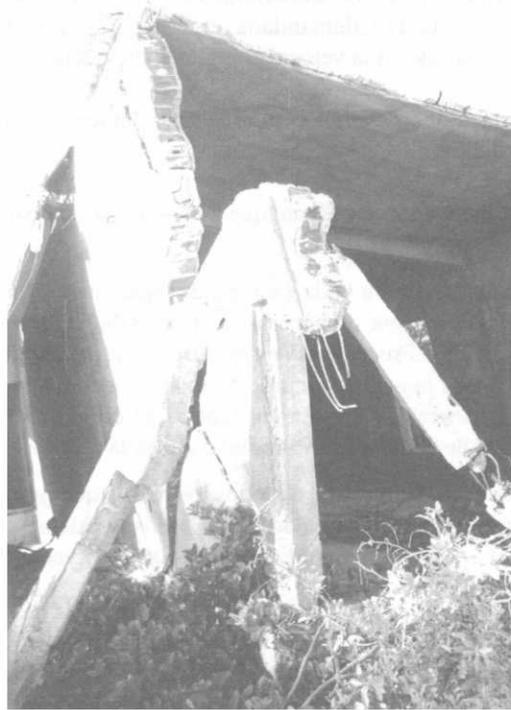
**Figura 5.2** *Falla de una estructura de mampostería confinada por efecto de viento (H. Toledo Huracán Pauline, Oaxaca, México, 1999)*
