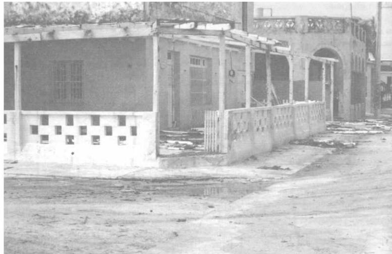
**Figura 5.5 Edificación con cubierta de techo a base de teja, ante la incidencia de vientos fuertes la teja se desprende y es levantada, dejando únicamente a la estructura de soporte**
