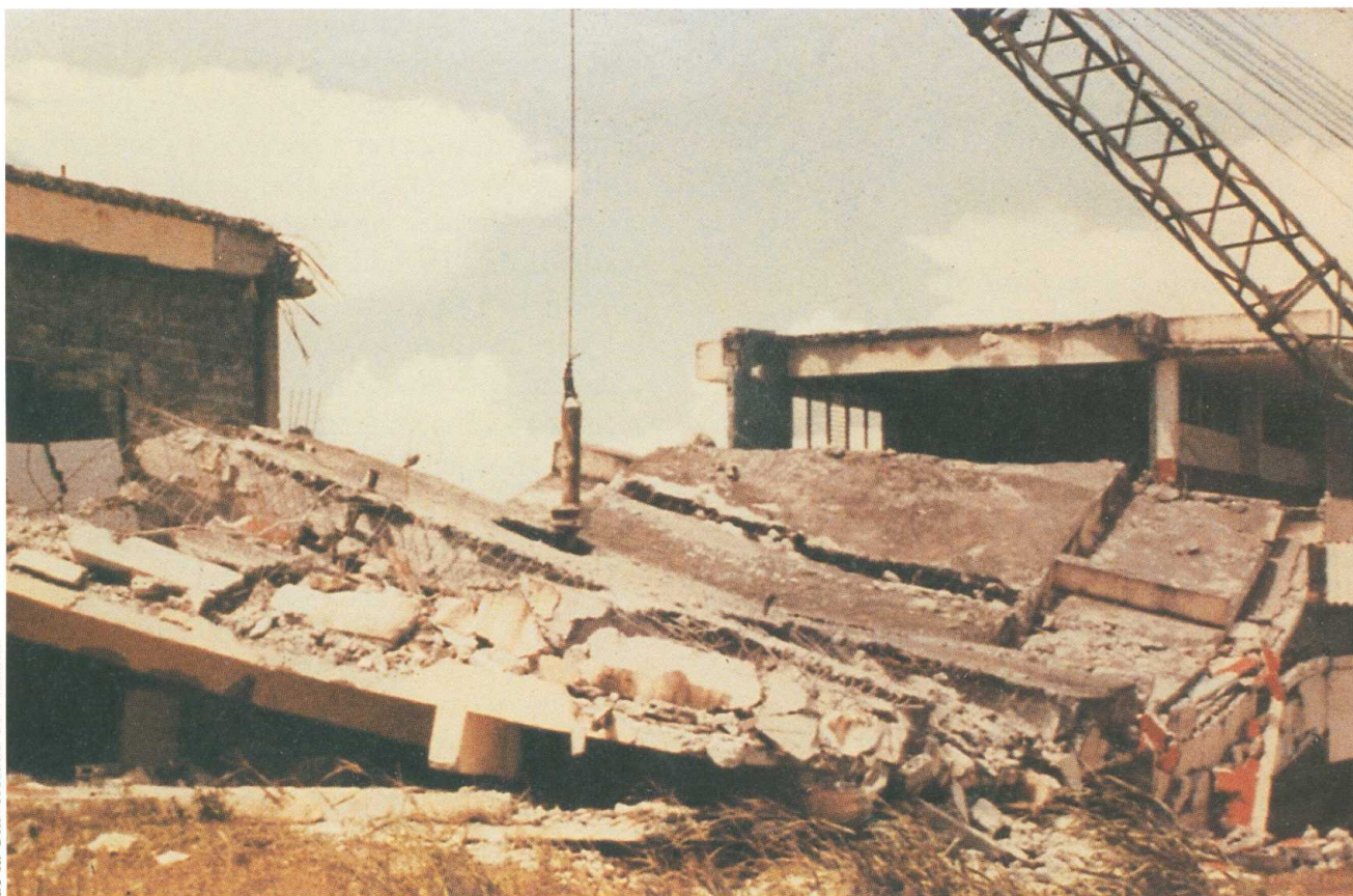
La destrucción de este Centro Educativo, fue producto del terremoto que sacudió la comunidad de Puerto Armuelles, en 1979.
