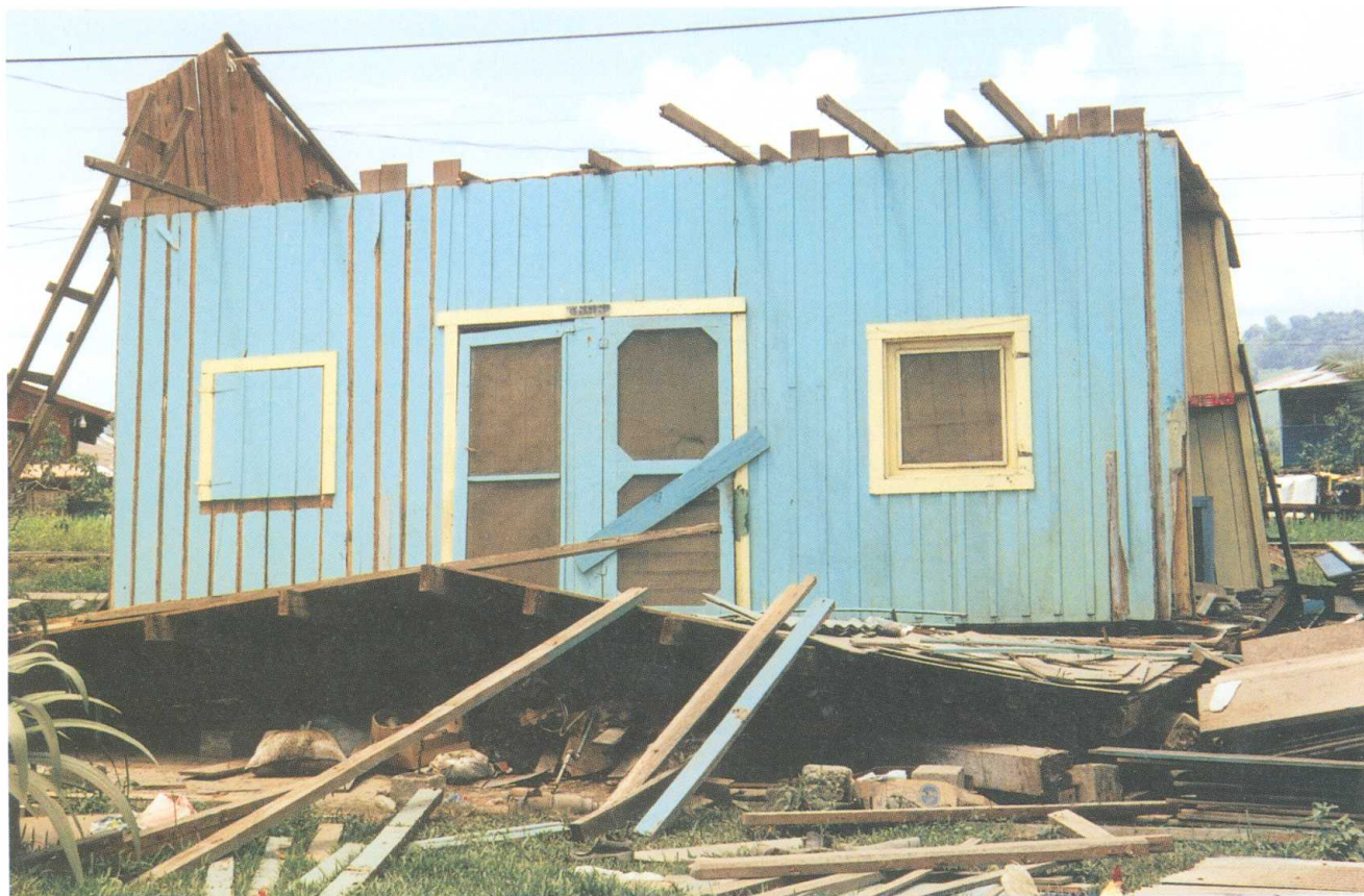
La furia del sismo, que sacudió a Bocas del Toro en 1991, causó desplome de edificaciones tal como la que observamos en esta fotografía.
