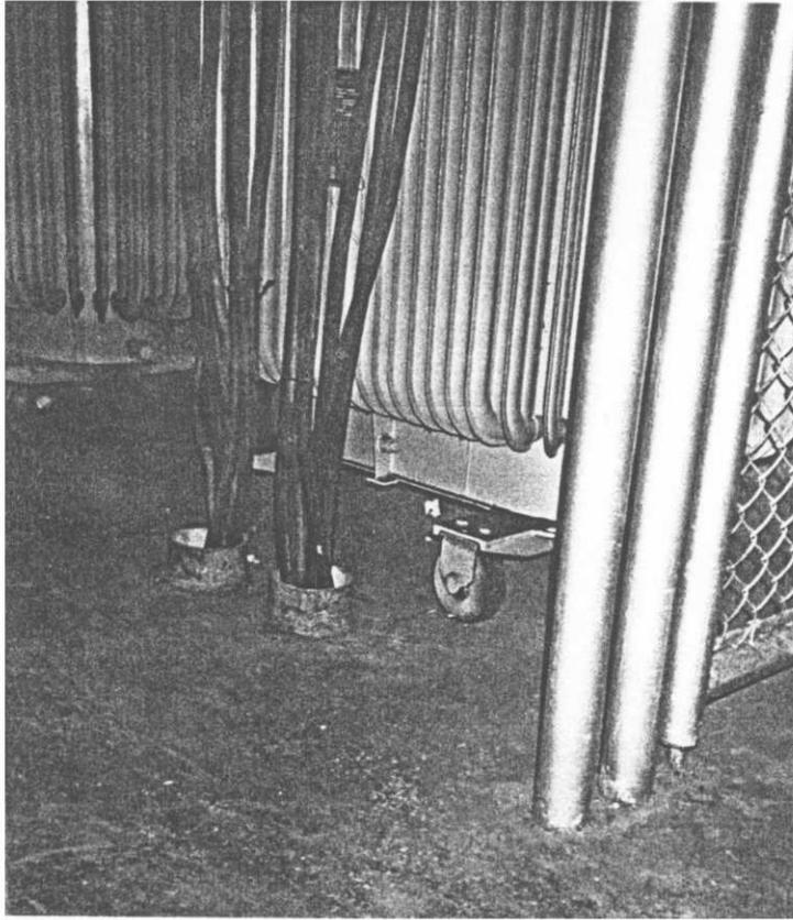
FOTO 17 Transformadores apoyados sobre ruedas.
