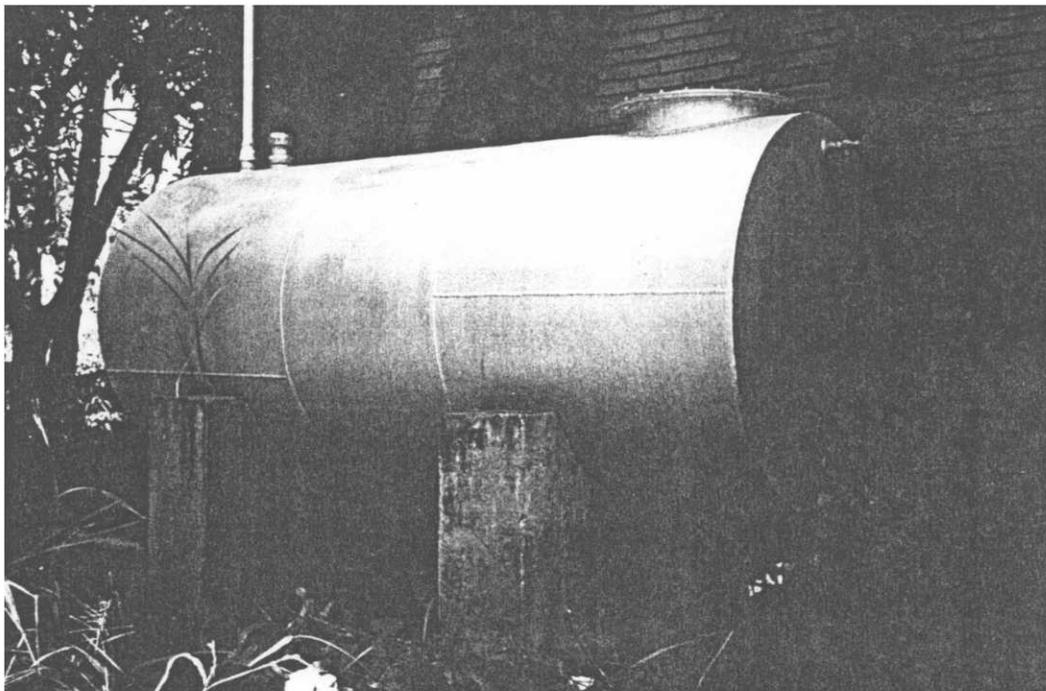
FOTO 20 Tanque de almacenamiento de combustible (gas-oil) sobre dos pilas de dimensiones generosas.
