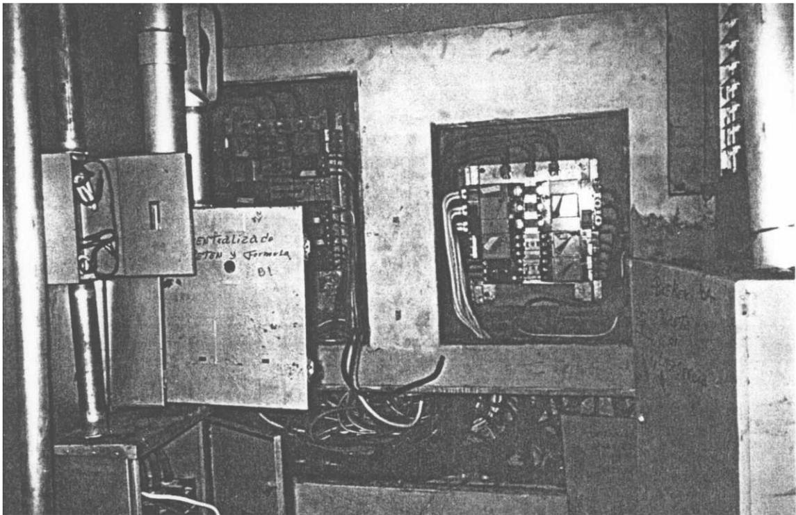
FOTO 18 Cables sueltos en la sala de tableros de distribución.
