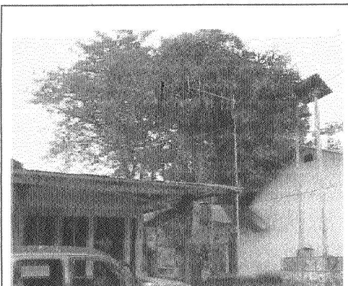
Foto # 3: Estación de radio en la base Sigma 2, en Guatemala. Se observa a la derecha de la antena una campana para la alerta en caso de inundaciones.
