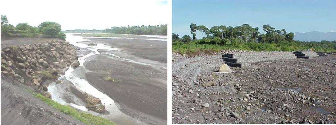
Fotos 9.1 y 9.2: Ejemplos de bordas para impedir desbordamientos. A la izquierda una borda con rocas. A la derecha una borda gavionadas con espigones. En ambos casos se reduce el poder erosivo del agua cuando fluye en la orilla de la borda. Nótese que en cada caso se ha dejado un margen de seguridad para que el río pueda ampliarse para acomodar enormes flujos de agua.
