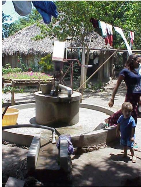
Foto # 6: un pozo de agua con protección contra contaminación.
