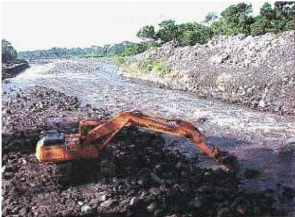
**Foto # 2:** *Dragado del río Samalá a la altura del puente Castillo Armas en Retalhuleu. Una de las obras de mayor envergadura de este tipo en Guatemala en la última década.*
