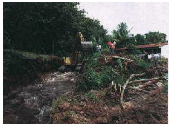
Foto # 5: Una retro-excavadora dragando y ampliando el cauce del río Ixpatz en San Sebastián, Retalhuleu.
