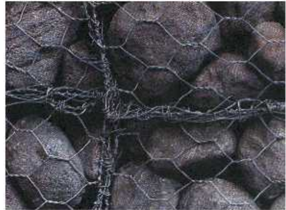
Foto # 6: vista del entrelazado de las cajas de gaviones para una borda típica.
