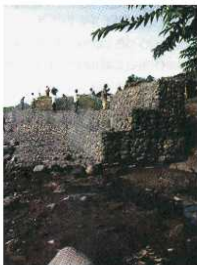
Foto # 10: estructura de la borda gavionada: se cuenta con un colchón de 20 centímetros de alto en la base, que se extiende 3 metros hacia fuera. Encima de este colchón se conforma la borda como una estructura triangular, con una base de tres metros y una altura de 3 metros. La borda se compone de una serie de cajas de gaviones armados con alambre galvanizado.
