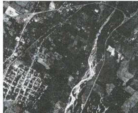
Foto # 9. Fotografía aérea del segmento de la cuenca del río Samalá a la altura de San Sebastián, la comunidad que se encuentra a la izquierda de la foto. En la fotografía el río fluye de arriba hacia abajo. Se observan la carretera costera, así como la vía del tren. También es notable el desborde que experimenta el cauce a la altura de San Sebastián comparado con el cauce en la sección superior. Dicho desborde es ocasionado por el asolvamiento del cauce, el cual es provocado por el material rocoso arrastrado desde la cuenca alta durante la época lluviosa. Foto cortesía del Instituto Geográfico Nacional de Guatemala.
