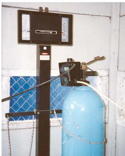
El sistema consta de un diafragma activado por un regulador a presión y un rotámetro que indica la tasa de flujo de cloro. El paso del cloro gas hacia el difusor es controlado por un regulador
