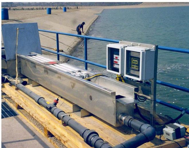
**Sistema de tubos paralelos al flujo instalado en una planta potabilizadora**
