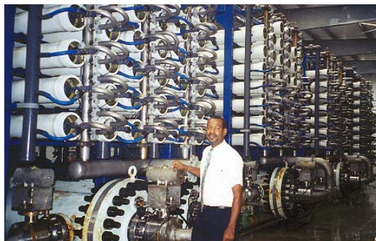
Instalación típica de un equipo de minifiltración (OI)
