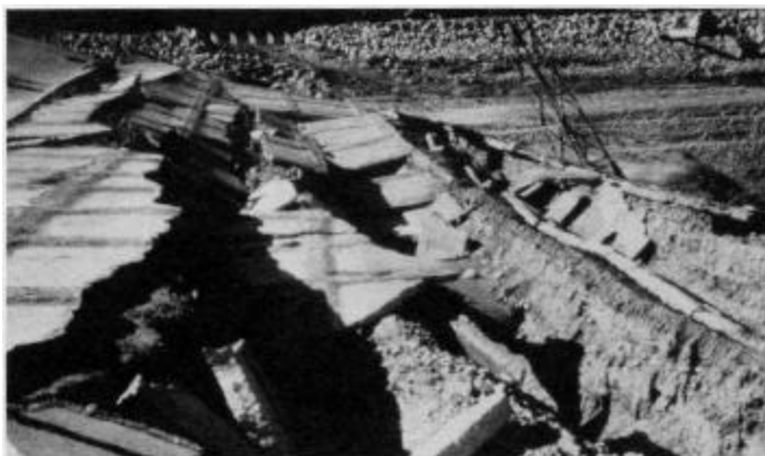
Figura 3-3 Represa del Reservorio Lower Van Norman (Calif.) que estuvo a punto de colapsar.
