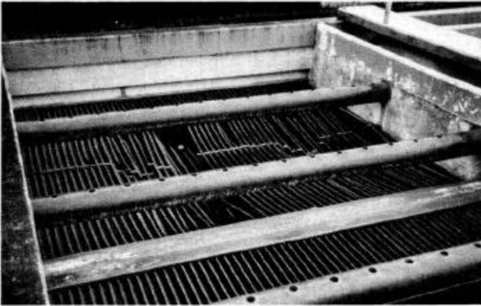
Figura 3-7 Los deflectores del floculador y las placas inclinadas del clarificador que resultaron dañados en la planta de tratamiento de agua de Limón, Costa Rica.
