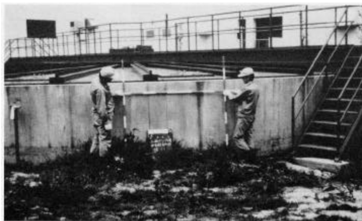
Figura 3-6 Tanque de aguas residuales que flotó debido a la licuefacción en Niigata, Japón
