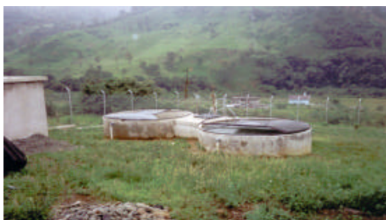
Proceso constructivo de la instalación de las cubiertas metálicas, para los tanques de reserva del sistema agua potable para la población de Sardinas, Provincia del Napo. 2003. Fuente: COOPI.
