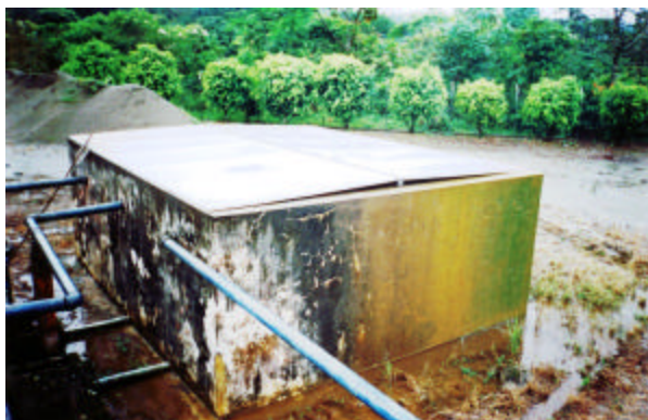
Estructura de los tanques desarenadores y filtro, con protección de cubiertas metálicas de la planta de tratamiento de agua de Las Palmas, cantón Chaco, Provincia del Napo. 2003. Fuente: COOPI.
