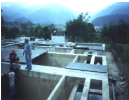
Trabajos de ubicación de la cubierta metálica en los tanques de sedimentación en la población de Baeza, Cantón Baeza, Provincia del Napo. Fuente: COOPI, 2003.
