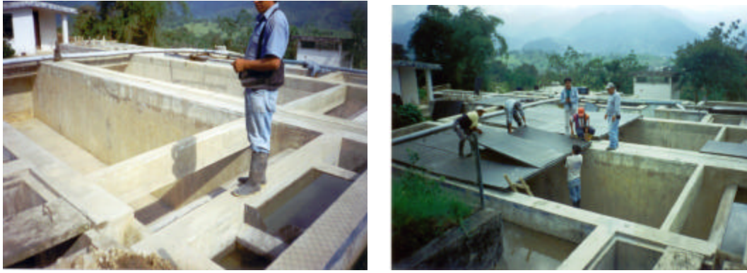
Trabajos de preparación y colocación de cubiertas metálicas sobre las unidades de sedimentador, canaletas y filtros en la población de parroquia de Borja, Provincia de Napo. 2003. Fuente: COOPI
