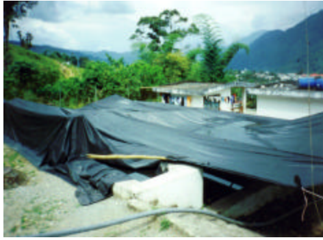
Estructura de captación y la protección con material plástico que se usó durante el evento de la caída de cenizas en el sistema agua potable para la población de El Chaco, cantón el Chaco, Provincia del Napo.
