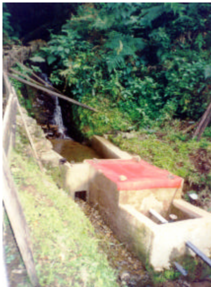
Estructura de captación y desarenador
