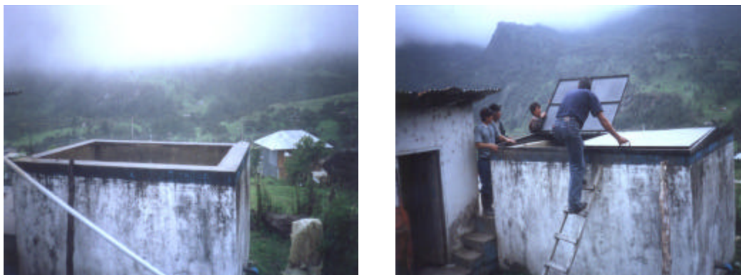
Tanque de filtración, del sistema de agua potable de Oyacachi, Provincia del Napo Antes y durante la colocación de las cubiertas o protecciones. Fuente: COOPI.
