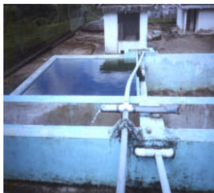
Vista general de las tuberías de captación de agua cruda, y los tanques de sedimentación de la población de Baeza, Cantón Baeza, Provincia del Napo. Fuente: COOPI, 2003.
