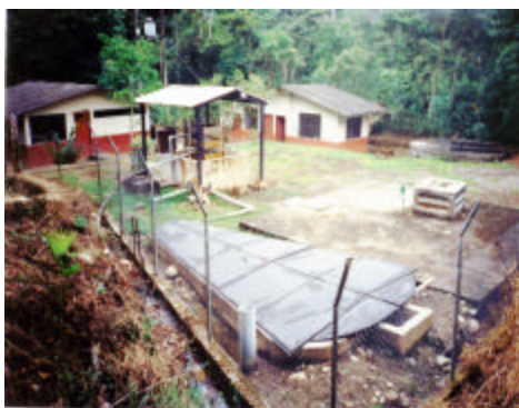
Panorámica de las instalaciones del sistema de la planta de tratamiento de agua potable de la población de Cháscales, Provincia del Sucumbíos. 2003. Fuente: COOPI.
