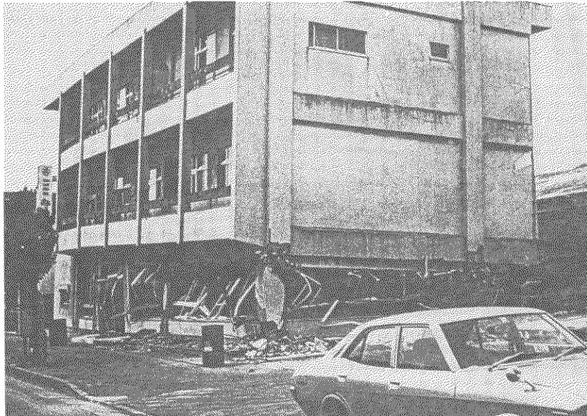
Fig. 6. Daño debido al efecto torsional
