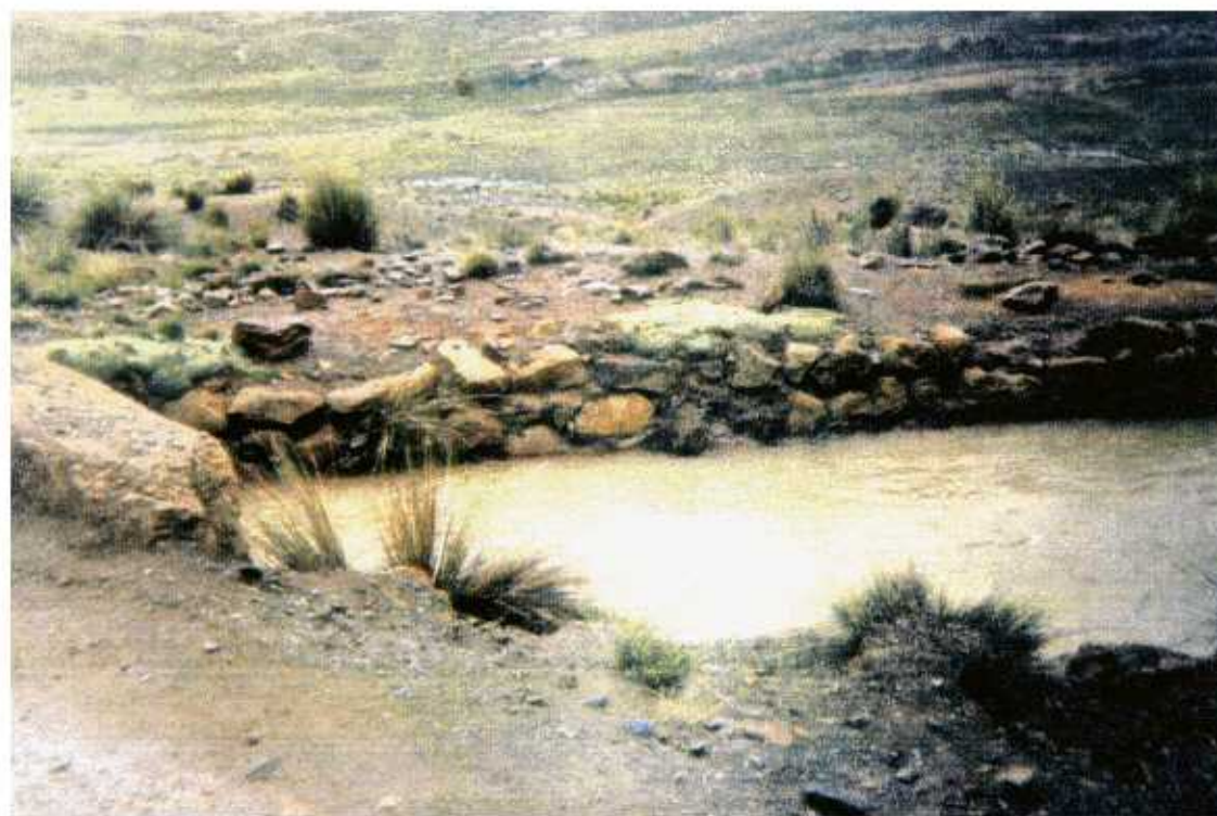
Fig.11.11. Aduccion Milluni, Canal de mangrosto en el leterio. Febrero 1998
