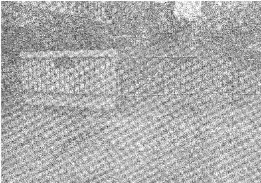
**FOTO 4.4: Pavimento fracturado
