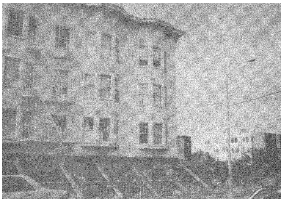
FOTO 5.3: DAÑOS TÍPICOS EN EDIFICIO DE ESQUINA, MARINA, SAN FRANCISCO
