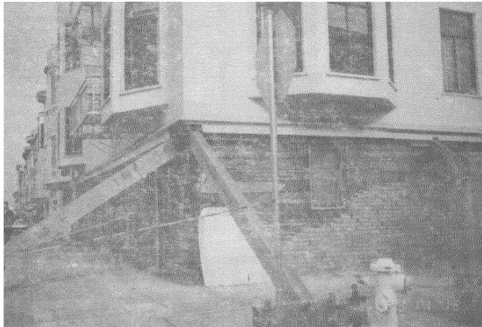
**FOTO 5.6 DETERIORO DE PORTICOS DE MADERA CUBIERTOS CON ALBAÑILERIA, MARINA, SAN FRANCISCO**
