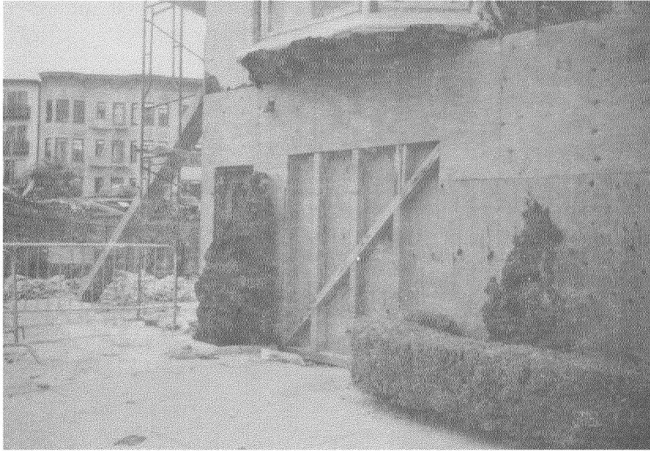
**FOTO 5.5. REPARANDO EL PRIMER PISO DAÑADO CON PANELES DE MADERA (TRIPLAY). MARINA, SAN FRANCISCO.**
