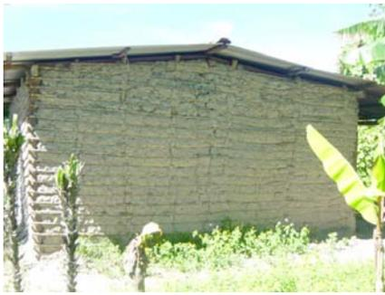
**2. La calidad de la construcción:** las paredes deben ir reforzadas siempre que sea posible ya sea con hierro, madera, vara de castilla, etc. Si se construye con tierra o con madera se deben de proteger del contacto directo con el suelo o con el agua.
