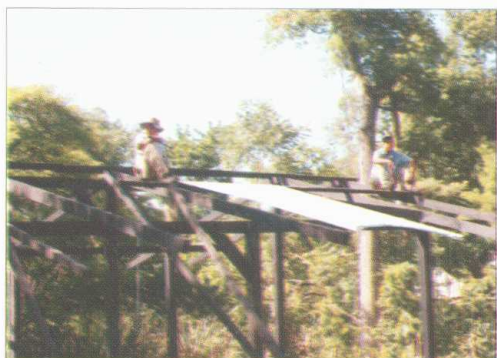
Colocando la lámina sobre la estructura de madera.
