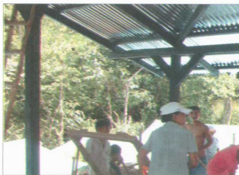
Detalle de estructura de techo con lámina.
