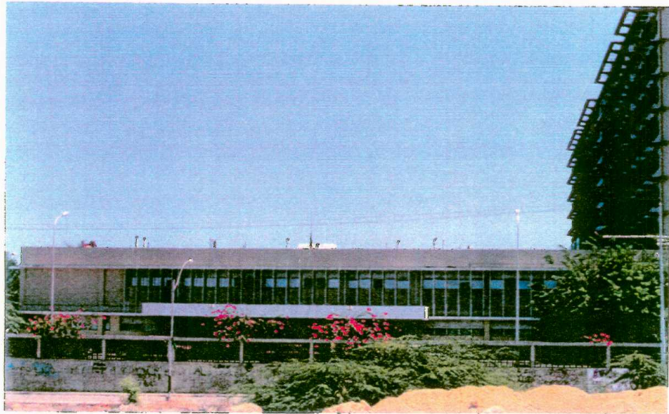
FOTO 5 Entrada de Emergencia Nueva (Fachada oeste)
