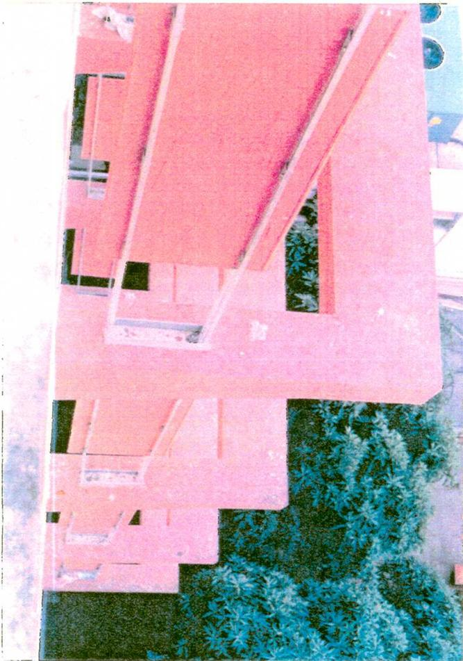
FOTO 12 Parasoles en la fachada norte. Sistema de fijación
