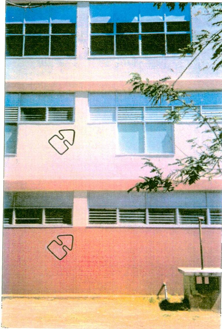
FOTO 11 Columnas Cortas en fachada
