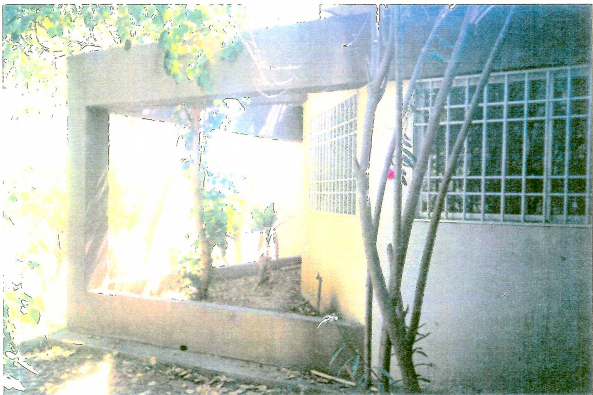
FOTO 16 Vista del Edificio de la Unidad de Oncología de forma octogonal, pero con pórticos ortogonales
