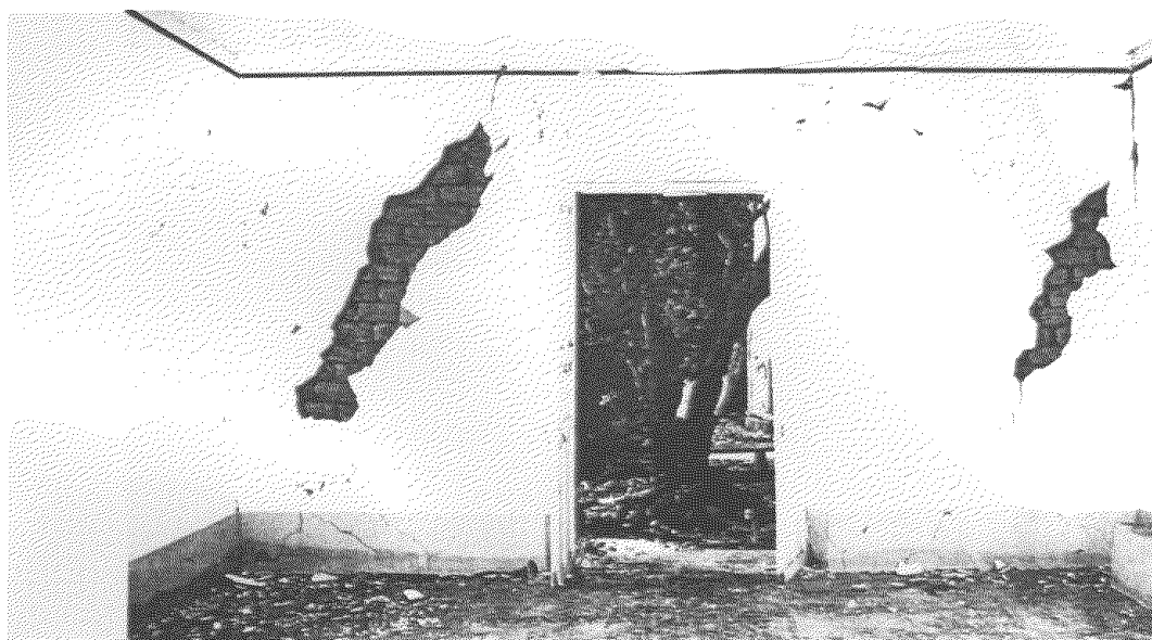
Foto 25. Vista Interna del daño de la Residencia Médica del Hospital Carmen López de Aiquile
