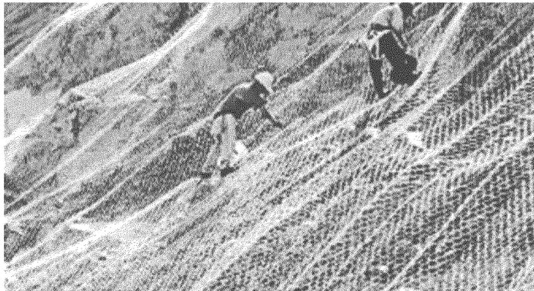
Enmallado de pared rocosa propensa a derrumbes.
