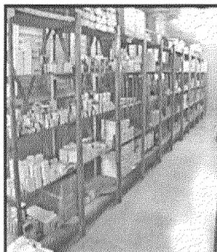
**Foto 18.** Estantes sin anclaje ni cintillos, en almacén de medicamentos. Pueden volcarse y caerse los medicamentos.
