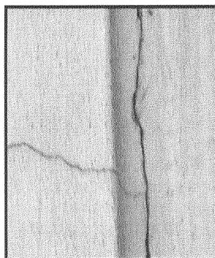
**Foto 22.** Grietas en paredes del Bloque Ginecobstétrico.
