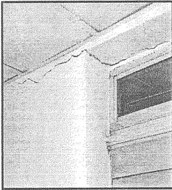
**Foto 25** Grietas en paredes pasillo de la sala de Neonatología producto de asentamientos
