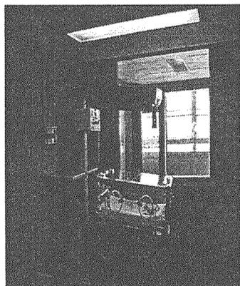
**Foto 32.** Split de aire acondicionado con insuficiente anclaje.
