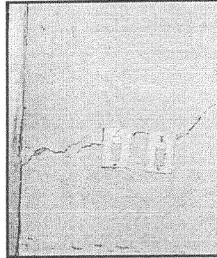
**Foto 26.** Grietas en paredes pasillo de la sala de Neonatología producto de asentamientos.
