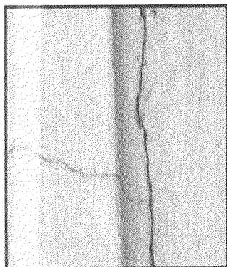
Foto 15. Grietas en paredes pasillo de la sala de Neonatología producto de asentamientos.
