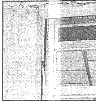
Foto 20. Separación de las uniones producto asentamientos.
