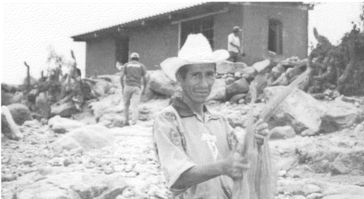
Figura 12: Beneficiarios trabajando en la construcción de su nueva vivienda
