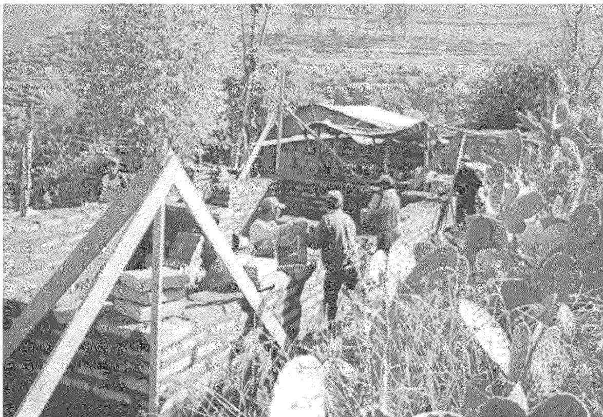
Figura 20 Construcción de muros de adobe
