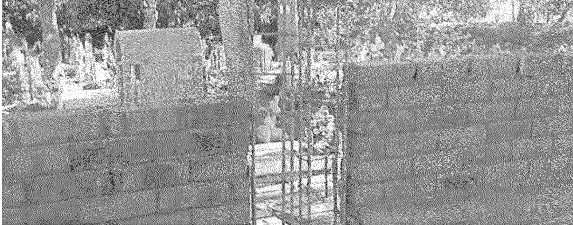
Figura 23 Preparación de junta de construcción entre dos columnas de una muralla de un cementerio municipal
